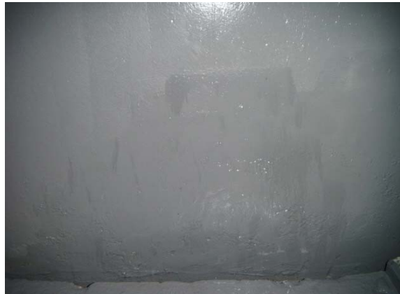
벽체 균열보수 사진 (영동)
