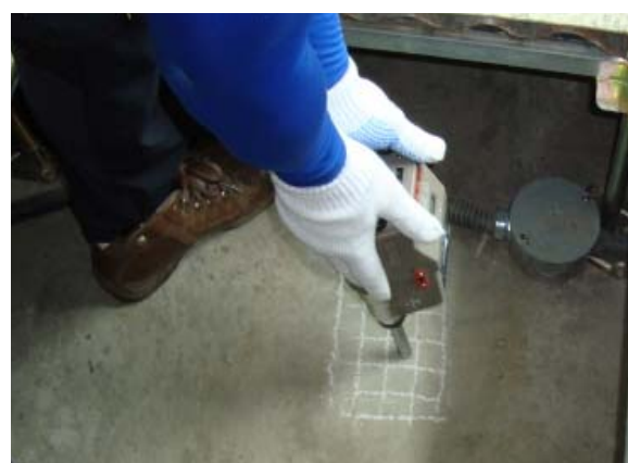
콘크리트 강도조사 (영동)
