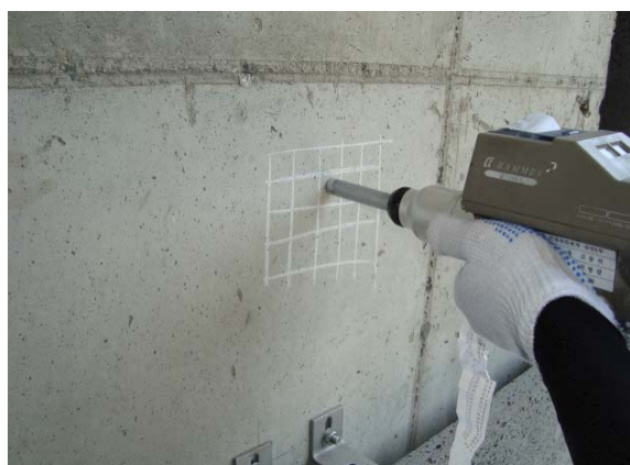
콘크리트 강도조사 (광주2)
