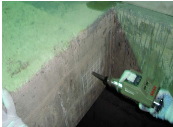
콘크리트 강도조사 (광동)
