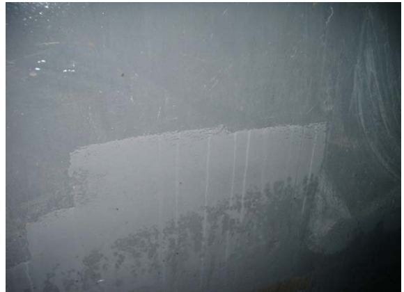
벽체 균열보수 사진 (영동)
