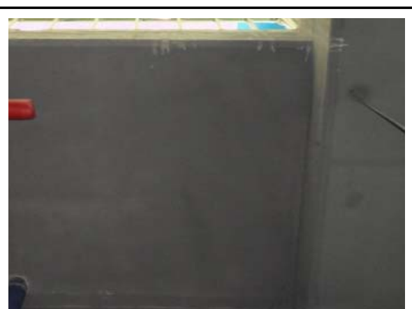
상부슬래브 균열 보수사진 (광동)
