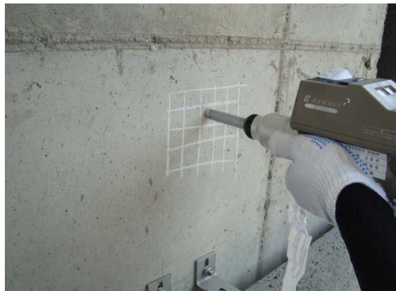
콘크리트 강도조사 (광주2)
