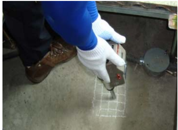
콘크리트 강도조사 (영동)
