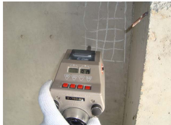
콘크리트 강도조사 (광주2)
