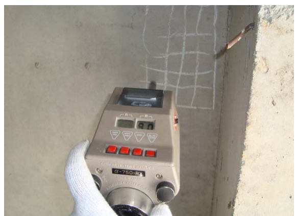
콘크리트 강도조사 (광주2)
