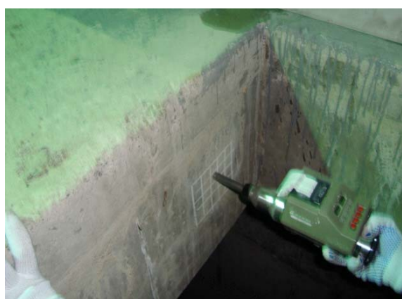
콘크리트 강도조사 (광동)
