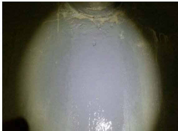
벽체 균열보수 사진 (광주2)
