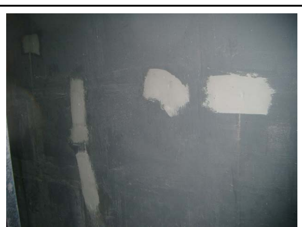
벽체 균열보수 사진 (광동)
